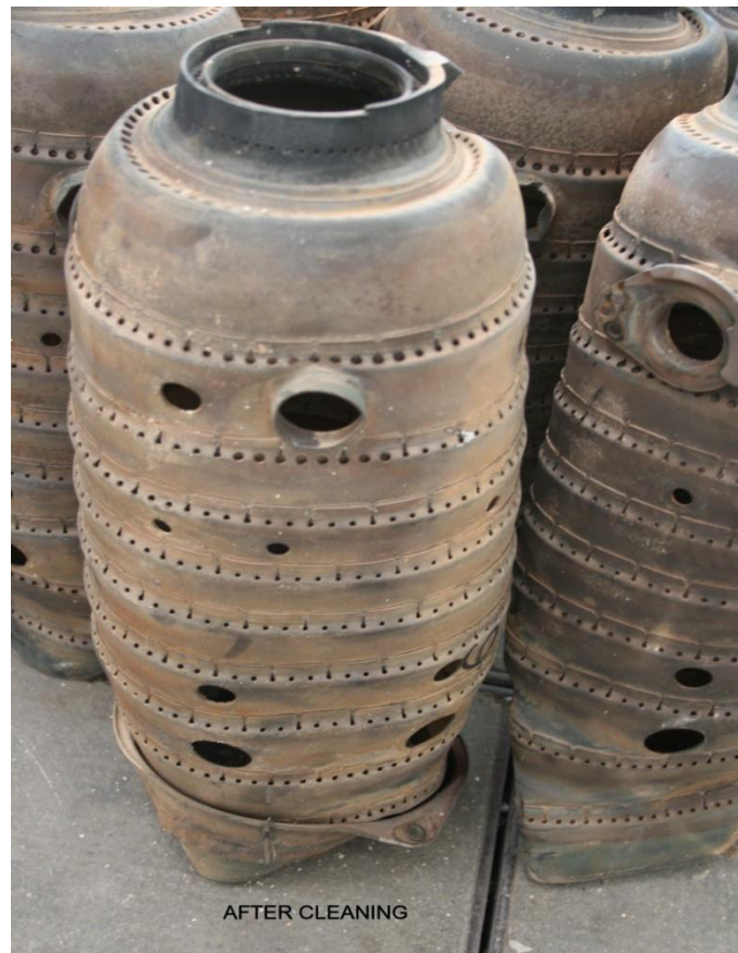
Fig. 42 : Chambres de combustion du moteur n° 1.
